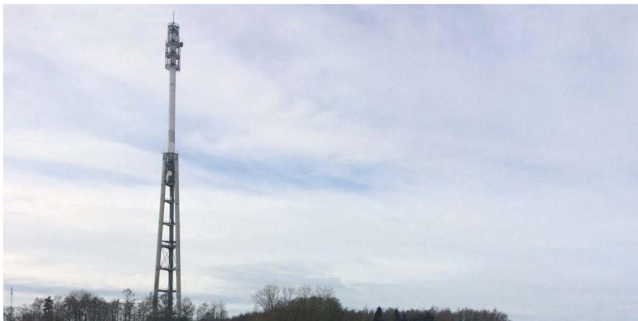
Pour que la technologie hertzienne, qui consiste à établir une connexion directe entre deux points via des antennes, fonctionne, aucun obstacle ne peut se trouver entre ces deux points. C'est pour cette raison que les antennes à faisceaux hertziens sont placées au sommet de tours aussi hautes.
